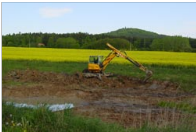
Obnova tůň u Lesáků. Foto: Ing. František Vondrák
