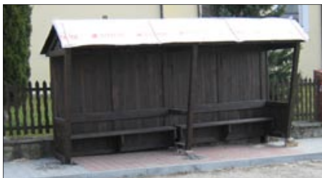
Nová čekárna ve směru na Načeradec. Foto: Jiří Herkloc
