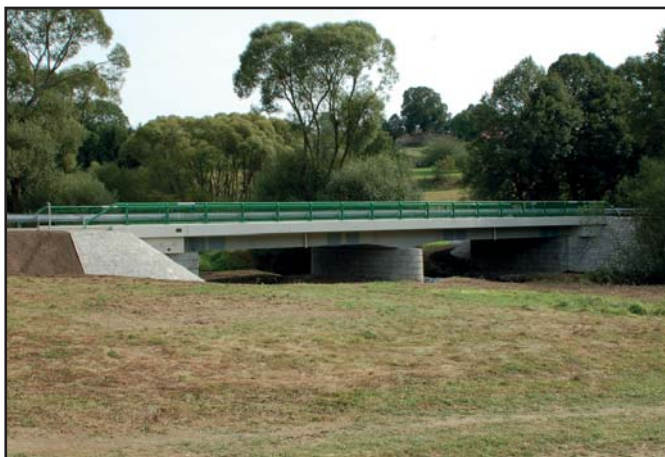
Nově opravený most na Velíš
