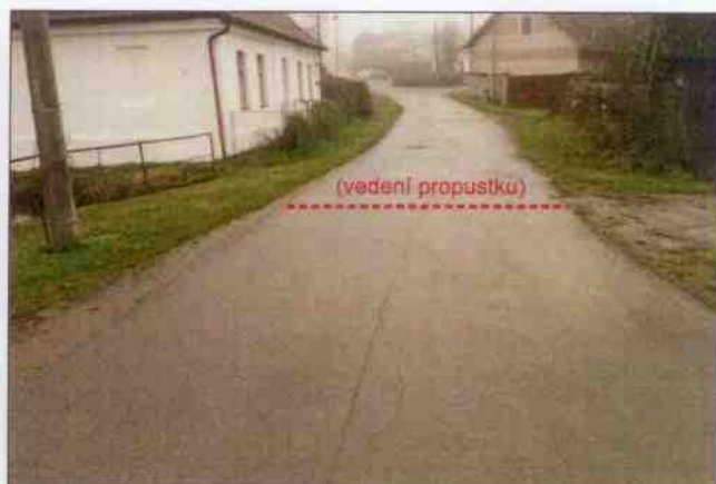
Propustek 1c - staničení 0,288 - celkový pohled
