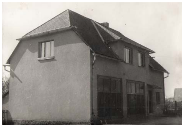
Hasičárna již s fasádou
